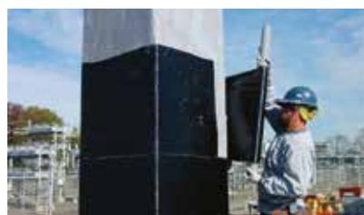
Un renforcement de structures est parfois nécessaire. Les systèmes **Sika CarboDur®** et **SikaWrap®** sont des systèmes composites PRFC pour le renforcement structural.
