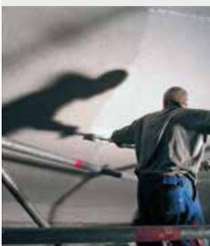
Parfois, il est nécessaire de prévoir des travaux de reprofilage ou de surfacage avec application du revêtement intérieur en sous-face de réservoir. Dans ce cas Sika préconise 2 types de solutions :
