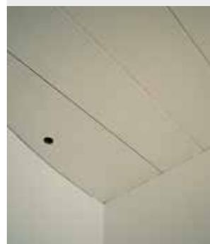
Pour la protection du béton en sous-face de réservoirs ou châteaux d'eau, le système : **Sikagard®-DWE**, est préconisé. Il se compose d'un primaire et de la résine **Sika Permacor® 3650**. Il bénéficie d'une ACS.
