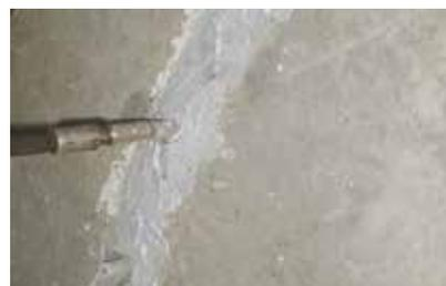
Parfois, l'ouvrage présente des fissures dans sa structure. Pour pouvoir les étancher et ainsi permettre à l'ouvrage de conserver sa fonction d'origine, Sika propose un ensemble de mousses, résines et gels pouvant être injectés à l'aide d'injecteurs différents selon les besoins.
