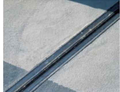
Les détails comme les joints, les gorges et les raccords de drainage requièrent une attention particulière pour créer un système totalement fonctionnel. Les systèmes de parking **Sikafloor®** peuvent être combinés avec des solutions de détail pour toutes les applications.
